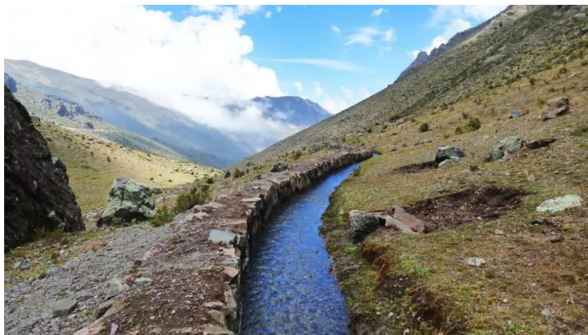
Figura 3. Sistema ancestral de amunas que infiltra escorrentía de lluvias para recargar acuíferos y sostener manantiales en época seca. Fuente: UNESCO (2024).
