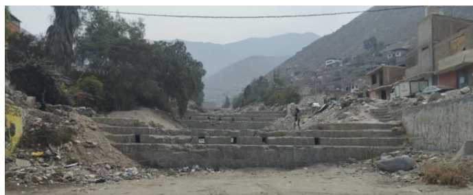
Figura 6: Dique de retención en el cauce de la quebrada Quirio
