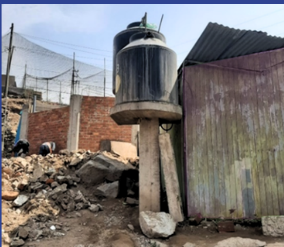
Fig. 4 Reservorios de agua al exterior de la vivienda con cubierta de bolsa de plástico y soporte inestable.
