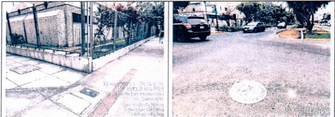
Fotografías N° 4³ y N° 5⁴: Se observa una de las salidas de la red interna desagüe que conduce las aguas residuales a un buzón de la red de alcantarillado público de Sedapal en dirección suroeste de la unidad fiscalizable y equidista en unos 20 metros.
