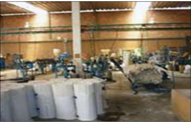
Se colocaron eternit translúcidos para el aprovechamiento de la luz natural
